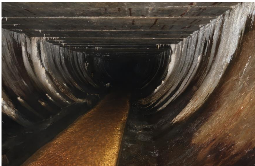
Obr. 4 Interiér odpadní chodby, viditelné jsou jednotlivé stropní panely, vápenné výluhy a prorýsování třmínků.
